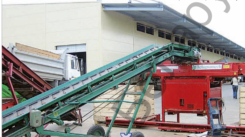
«Объект под ключ». Картофелехранилище на 12 тыс. тонн в РУП «Толочинский консервный завод» с комплексом машин для сортировки, закладки на хранение и предреализационной доработки картофеля и лука
